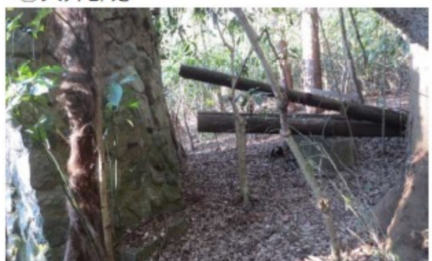
⑥橋脚の一部
