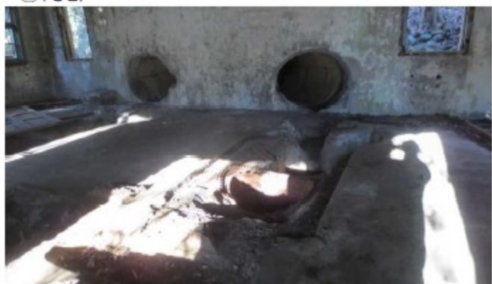
③導水管跡
