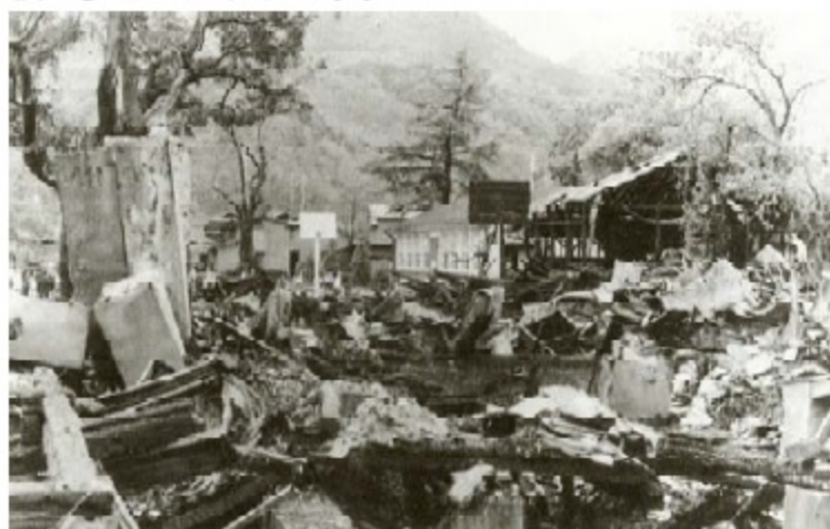
<写真3>火災後の惨状
